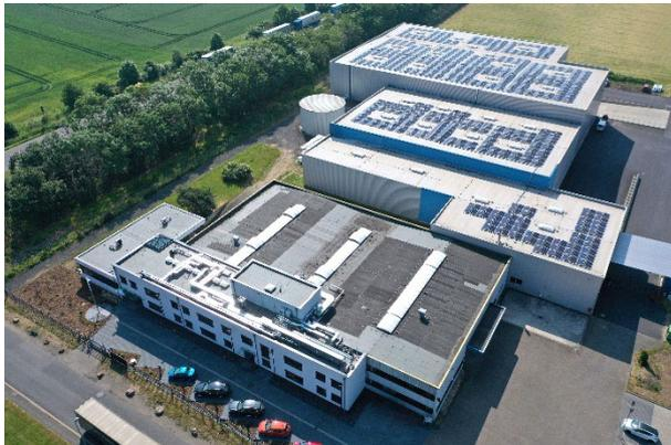
*„Am Standort in Euskirchen sind Produktion, Entwicklung, Vertrieb und Verwaltung von PGP angesiedelt. Die Photovoltaikanlage produziert 289.000 kWh Strom jährlich und deckt einen Großteil der verbrauchten Energie ab.“*
